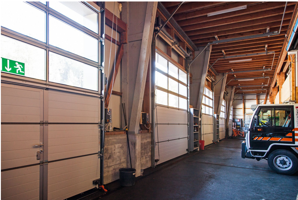
Industrie-Sectionaltor Innenansicht: Mit speziellen Rücklaufschienen
